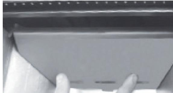
Fig. 14: levantar la placa cortafuego
