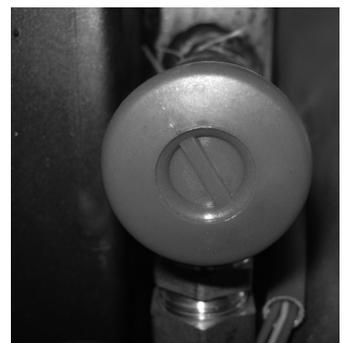
**Válvula de seguridad:** esta válvula actúa para evitar la sobre presurización del sistema hidráulico. Si la presión del calentador o de la planta excede de 2,5 bar se drena el agua del circuito.
