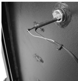
**Sonda de temperatura agua:** si la temperatura del agua se aproxima a la temperatura de bloqueo (85°C) a sonda impone para detener la alimentación de los pellets.
